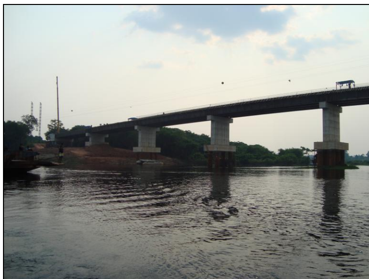
Figura 30 – Ponte sobre o Paraná do Careiro. A ponte passou bastante tempo para ser finalizada, faltavam as “cabeceiras da ponte”. Isto dificultava o escoamento da produção, assim como acesso de outros serviços como o corpo de bombeiros.
