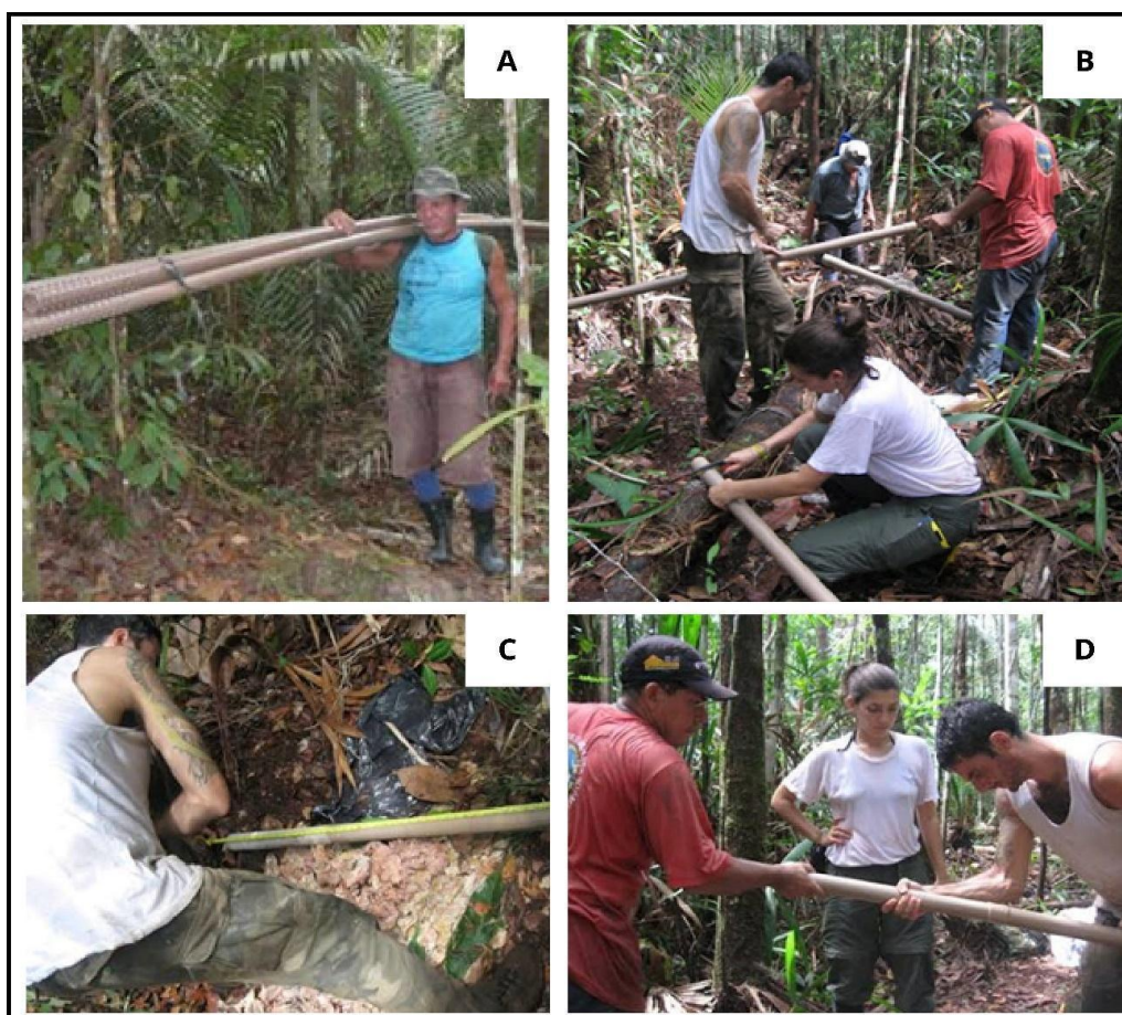
Figura 9 - Instalação dos piezômetros em um módulo RAPELD. Em A, a equipe transportando os canos; em B, medida de 2 m no cano; em C, corte dos canos; e em D, montagem do cano para que fiquem com o tamanho desejado.
