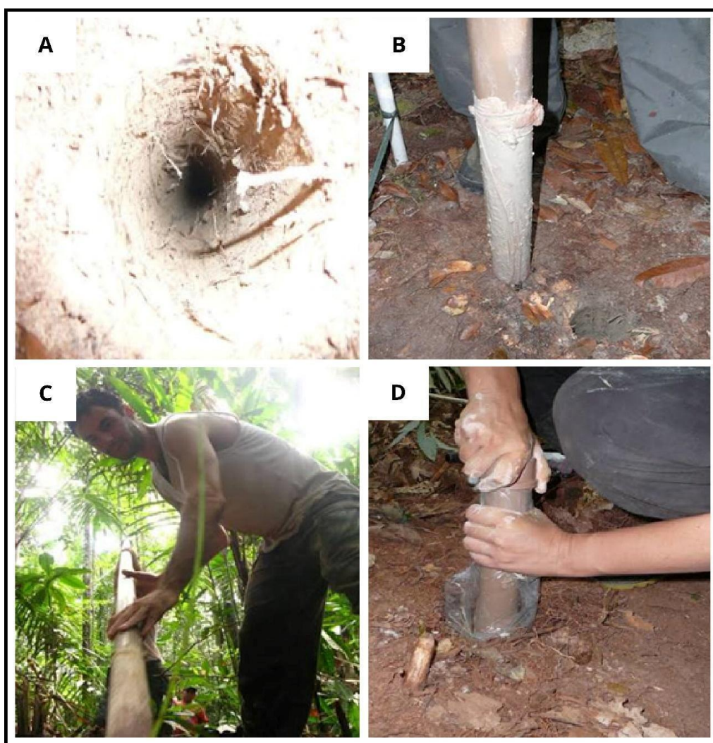
Figura 10 - (A) Poço onde será inserido o piezômetro, (B) posicionamento do piezômetro na posição vertical ao lado do buraco, (C) introdução do piezômetro até 7m de profundidade e (D) piezômetro sendo fechado com a tampa de PVC (CAP).
