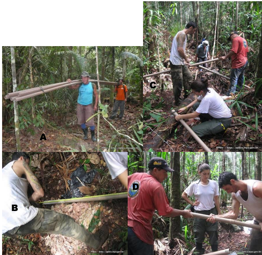
Figura 8 – A) Transporte dos canos, B) medida de 2 m no cano, C) corte dos canos e D) montagem do cano para que fique com 8 m.
