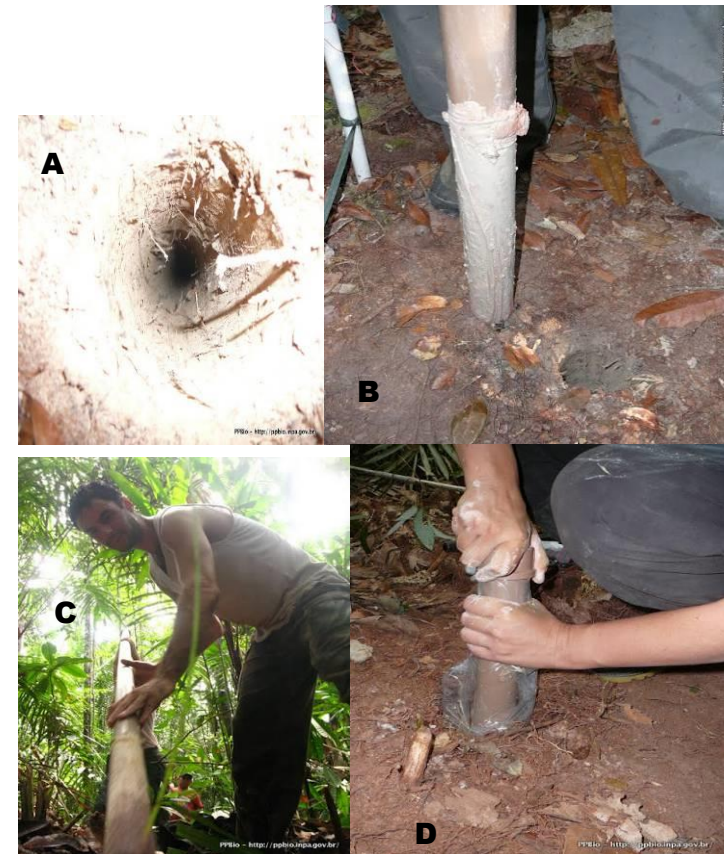
Figura 9 – (A) Poço onde será inserido o piezômetro, (B) posicionamento do piezômetro na posição vertical ao lado do buraco, (C) introdução do piezômetro até 7m de profundidade e (D) piezômetro sendo fechado com a tampa de PVC (CAP).
